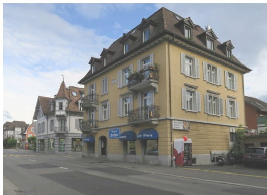
Abb. 15: Kleinteilige Bebauungsstruktur mit publikumsorientierter Nutzung an der Landstrasse (Beispiel Landstrasse 6 und 8)
