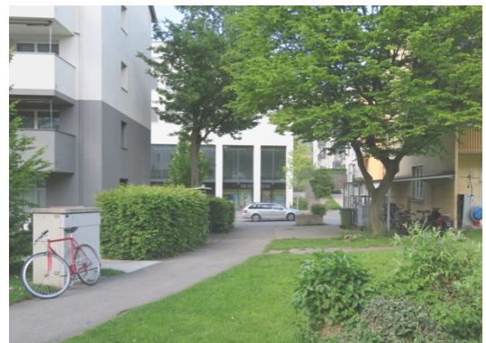
Abb. 9: Wegverbindung zwischen den Gebäuden Landstrasse 102/104 und Rankstrasse gewährleistet Orientierung und kurze Wege
