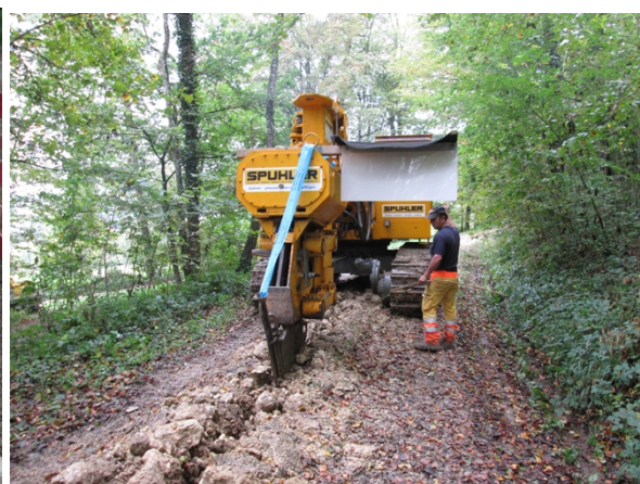
Abbildung 5: Grabenloses Verlegen von Quellwasserleitungen durch Einpflügen
