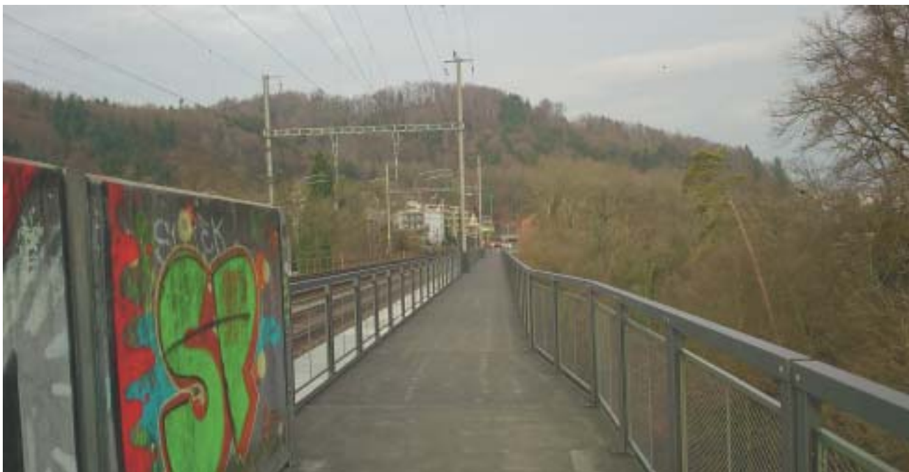
Fuss- und Radweg Limmatbrücke.
