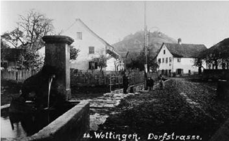
Ansicht der Dorfstrasse Wettingen, hinten das alte Casino
