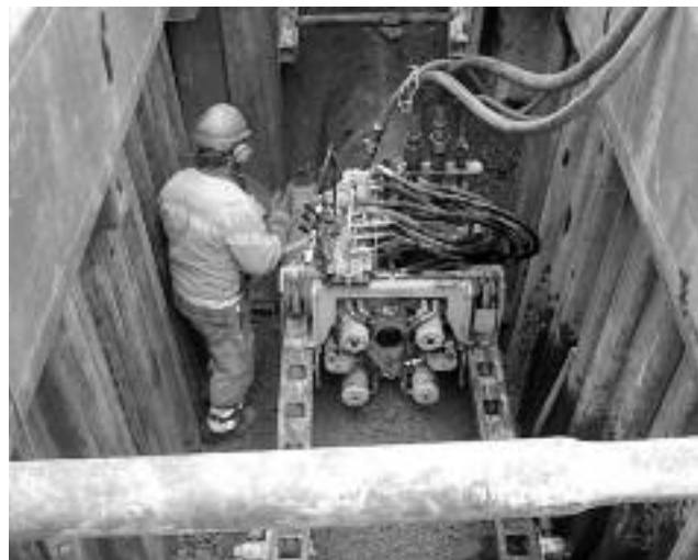
Unterquerung des Bahntrassees mittels Imlochbohrung im Bereich des Bahnübergangs Fohrhölzlistrasse
