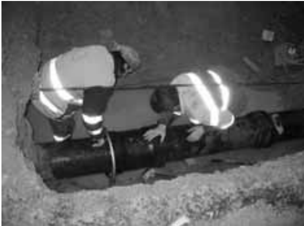
Reparatur Leitungsbruch Rebbergstrasse
