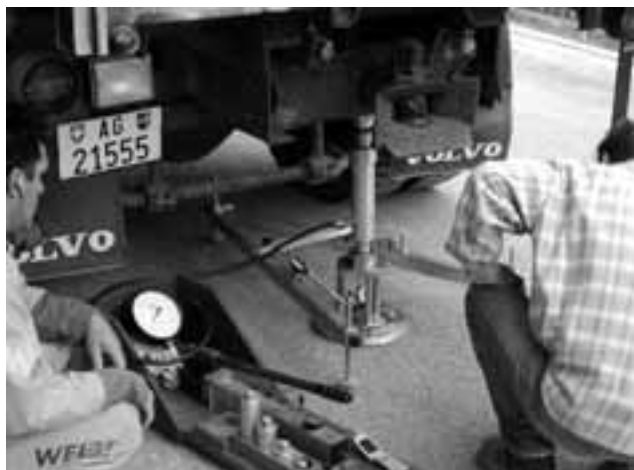
Verdichtungskontrolle der Fundationsschicht (ME-Messung)
