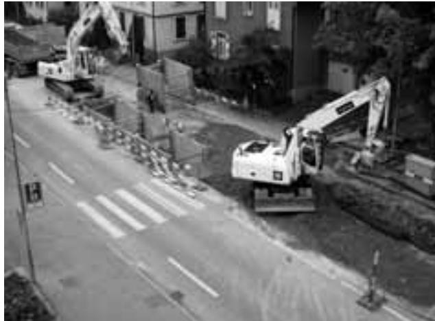
Kanalbau Zentralstrasse, Bereich Rathaus
