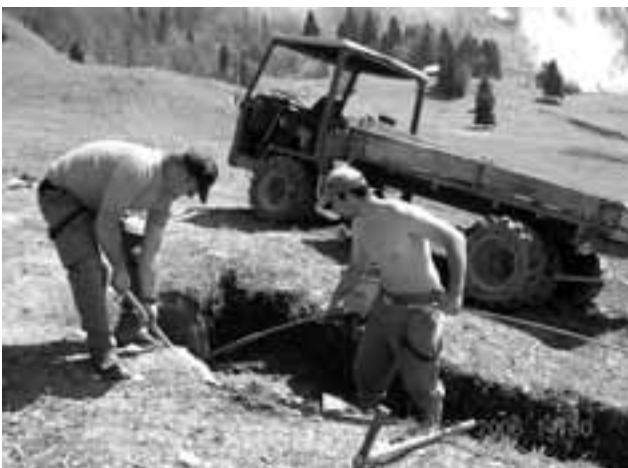
Freilegen von Entwässerungsgräben
