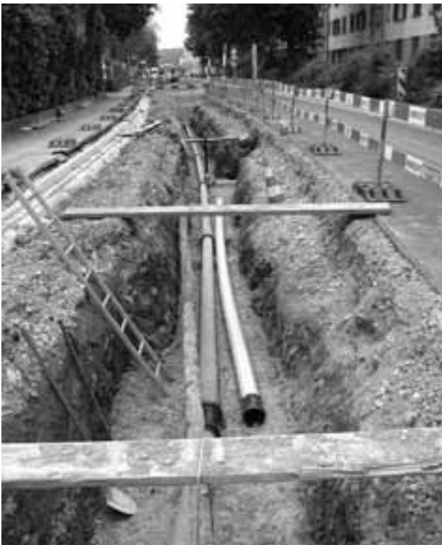
Ersatz Hauptleitung Seminarstrasse
