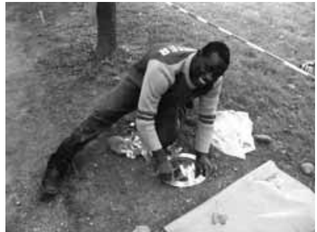
Bodenstrahlereinbau im Brühlpark
