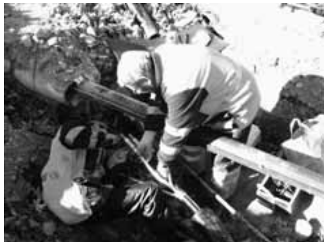
Verbindungsmuffe Kupfer-Aluminiumkabel
