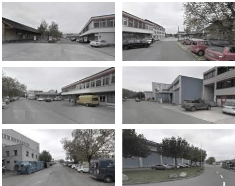
Abbildung 1: Bestehende Situation im Bahnhofareal, 2015 [Quelle: Google Street View]
