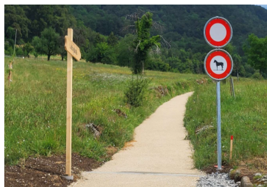
Lättengässli nach Sanierung 2023
