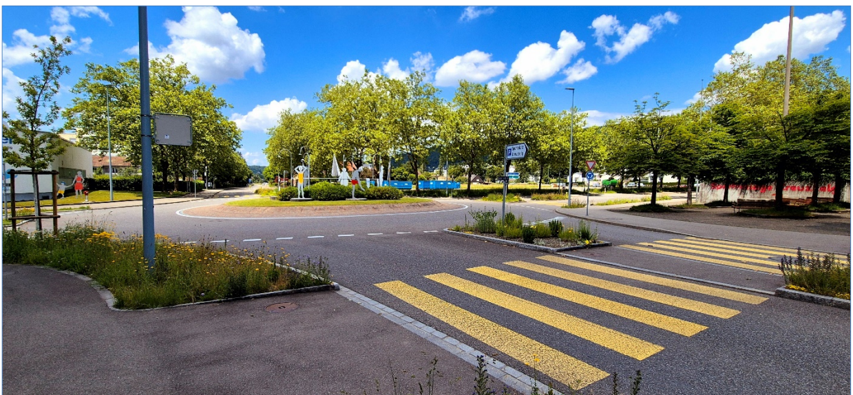
Abb. 3: Kreisel "Halbartenstrasse / Zentralstrasse"
